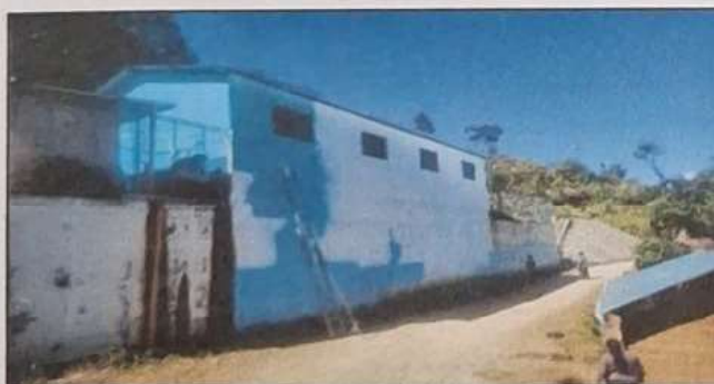
Foto 5: pintada en proceso en aulas, muro de contención y bajada de agua, para mejorar la circulación de agua
