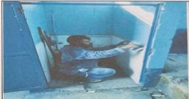
Foto 4: colocación de azulejo en mingitorio para niños
