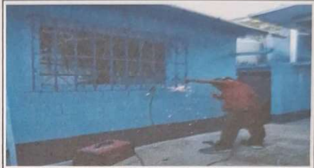
Foto 2: 6 balcones en proceso de instalación de diferentes medidas en aulas
